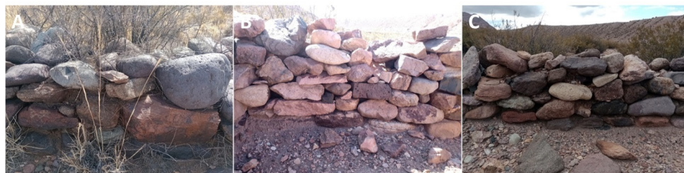
Figura 7: Tipos de muro A) Muro recto de lienzo doble indeterminado con mampuestos acomodados y sin presencia de mortero (Tambillos UA1R2); B) Muro recto de lienzo doble indeterminado con mampuestos acomodados y presencia de mortero (Ranchillos UA1R2); C) Muro recto de lienzo doble indeterminado con cantos alineados y sin presencia de mortero (Ranchillos UA3R4).
