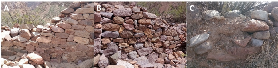
Figura 6: Tipos de muro: A) Muro recto de lienzo doble con relleno con cantos alineados y unidos por mortero (Tambillitos UA4R2); B) Muro recto de lienzo doble entrecruzado con cantos alineados sin presencia de mortero (Tambillitos UA1R18); C) Muro recto de lienzo doble entrecruzado con cantos alineados y unidos por mortero (Tambillos UA1R15).
